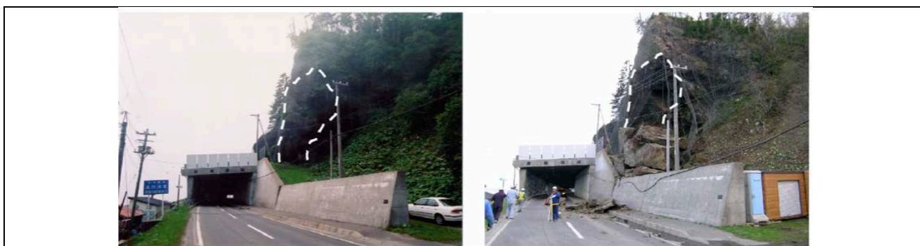
【図 2.2 岩盤崩落の例 左：崩壊前 右：崩壊後】(清水順二氏作)
