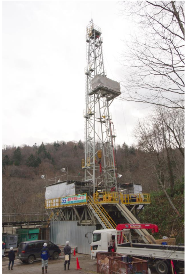
札幌市豊羽地域・湯の沢における地熱開発調査のボーリング
