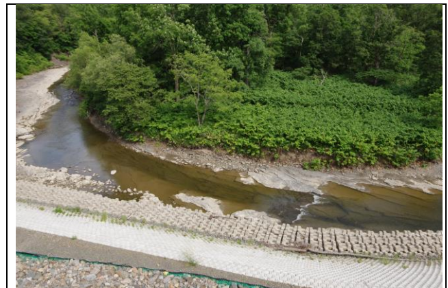
写真2 押え盛土川側の護岸工
